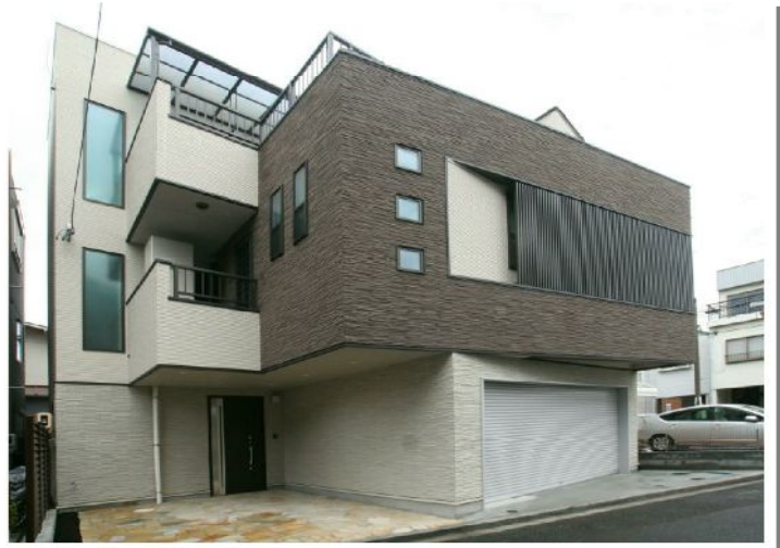
7月に竣工したS邸 鉄骨造であることのメリットを活かして自社設計しました。
