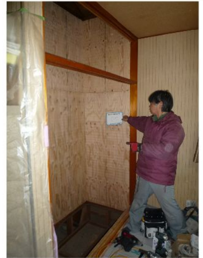
押入の壁に合板を貼り、耐震補強した様子。
