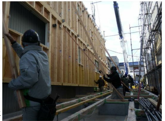
クレーンで壁全体を吊って、建て寄せ施工をしました。
