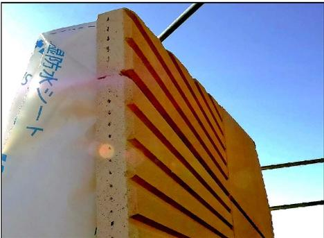
耐火性に優れ、高強度な厚さ50mmのALC板を外壁に採用しています。
