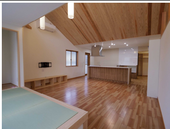
勾配部分の天井材はオクシズ材の杉板です。
